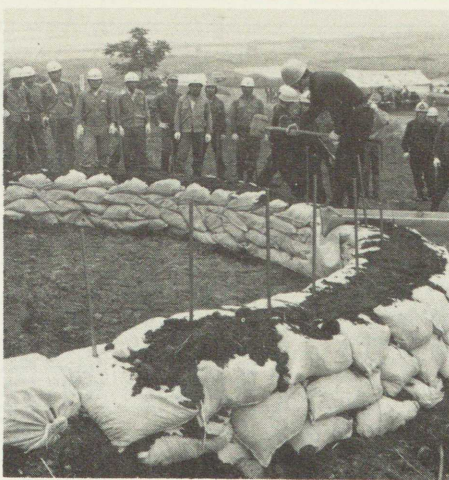
最後のくい打ちを終えて完成する土のう造り。
